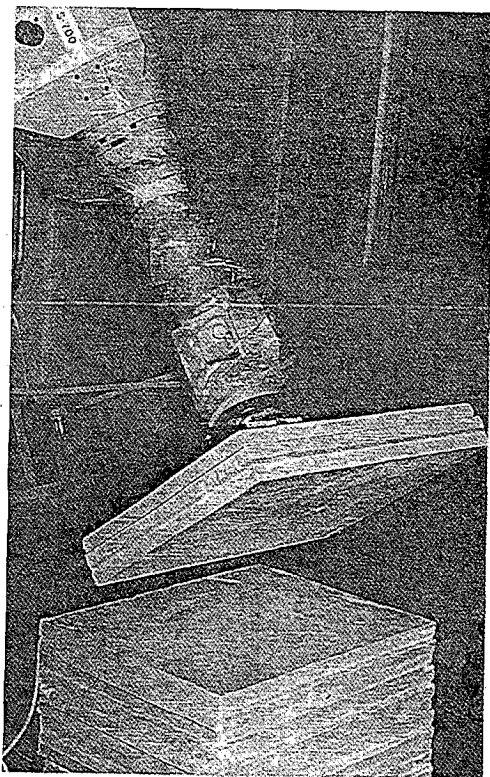
FIGS. 22.a,b,c y d. Robot multitarea para operaciones de interior (NBRI, Israel). a) Pintando. b) Colocando piezas cerámicos para revestimiento de pared. c) y d) Ejecutando una pared de bloques ligeros.
